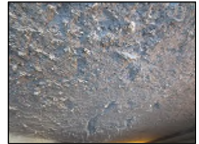
Photo N° 663 ECH-N°1 FLOCAGE -- LOCAL POUBELLE Plafonds blanc cotonneux
